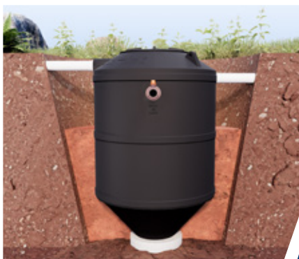
Figura 9 - Aterro completo com compactação.
