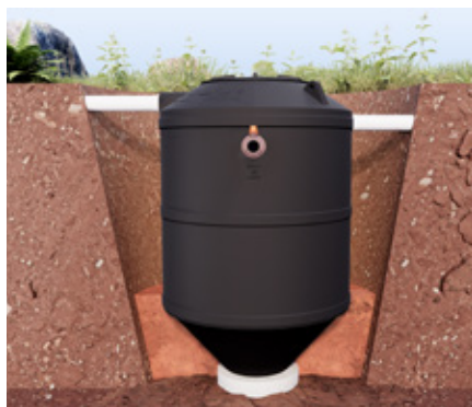
Figura 8 - Aterro com compactação até o início da nervura central.
